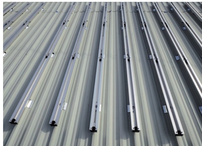
① 屋根面にPV金具を固定後、架台を取付けます
