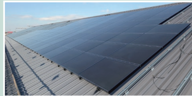
④ ソーラーパネルを設置します
