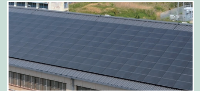
⑤ 施工完了後の屋根面
