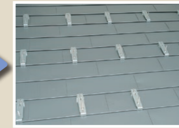
② PV金具を取付けた屋根面
